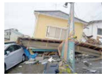
住宅の耐震化は必須(市提供写真)
